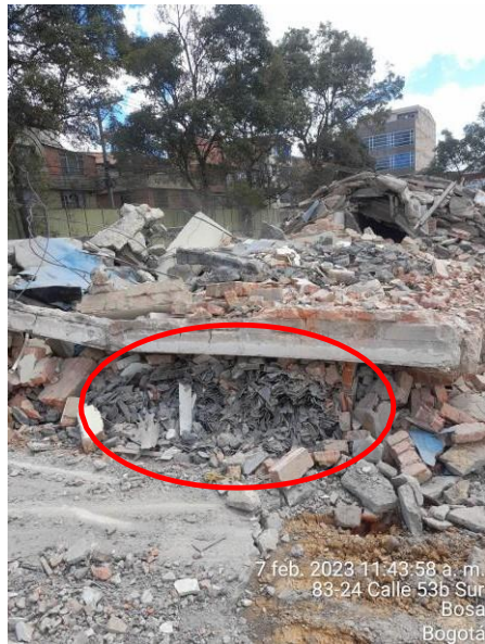
Evidencia de acopio de residuo peligroso (tejas con asbesto) inmerso en demolición. Fecha: 07-02-2023
