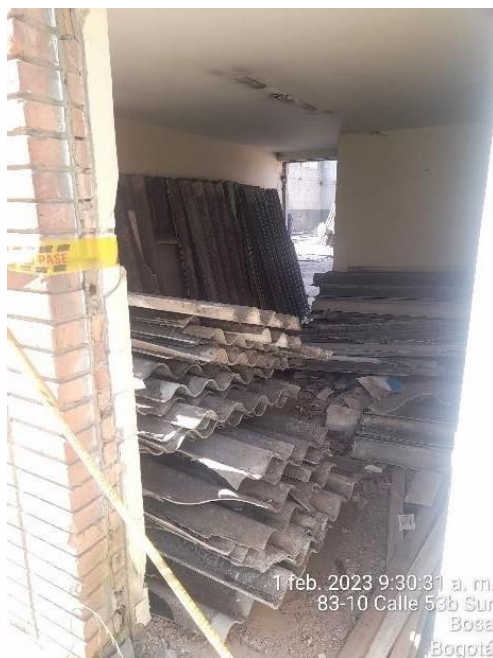
Tejas de asbesto sin proteger y sin etiquetar- área de acopio sin señalizar y delimitar. Fecha: 01-02-2023.
