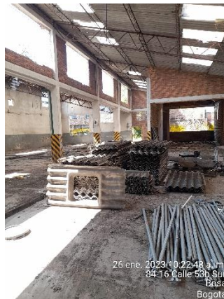
Tejas de asbesto sin proteger y sin etiquetar- área de acopio sin señalizar y delimitar. Fecha: 26 y 27-01-2023.
