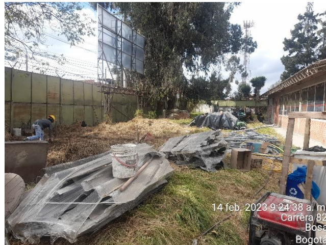
Presencia de residuos con asbesto (tejas) a la intemperie, sin señalizar y delimitar.
