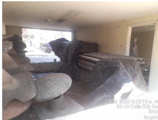
Tejas de asbesto sin proteger y sin etiquetar- área de acopio sin señalizar y delimitar. Fecha: 01-02-2023.
