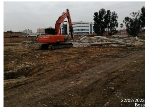
Se continua con la demolición de vigas y columnas para separar hierro de escombro.
