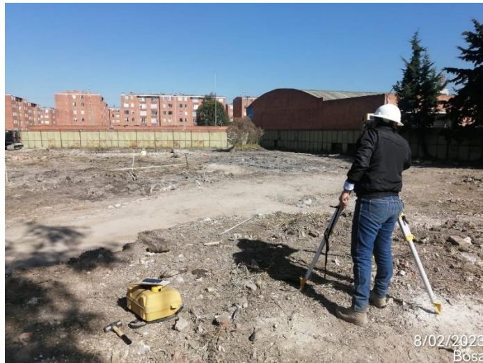
Figure 2 Nivelación terraza 3
