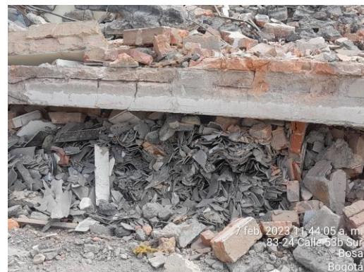
Evidencia de acopio de residuo peligroso (tejas con asbesto) inmerso en demolición. Fecha: 07-02-2023
