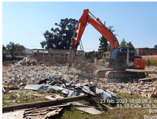
Se continua con la demolición de vigas y columnas para separar hierro de escombros.
