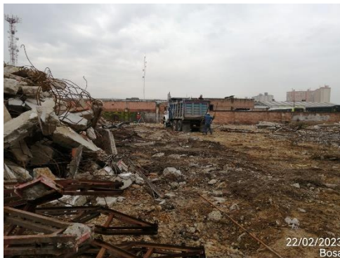
Se continua con la demolición de vigas y columnas para separar hierro de escombro.
