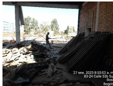
Tejas de asbesto sin proteger y sin etiquetar- área de acopio sin señalizar y delimitar. Fecha: 26 y 27-01-2023.
